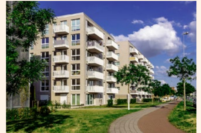
Sozialer Wohnungsbau Marcuskaje, Überseestadt
