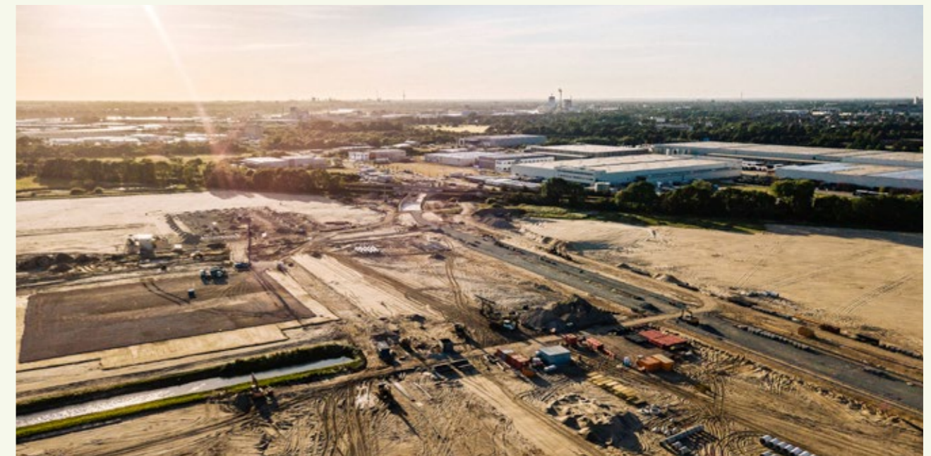
Erschließung des zweiten Bauabschnitts im Gewerbepark Hansalinie
