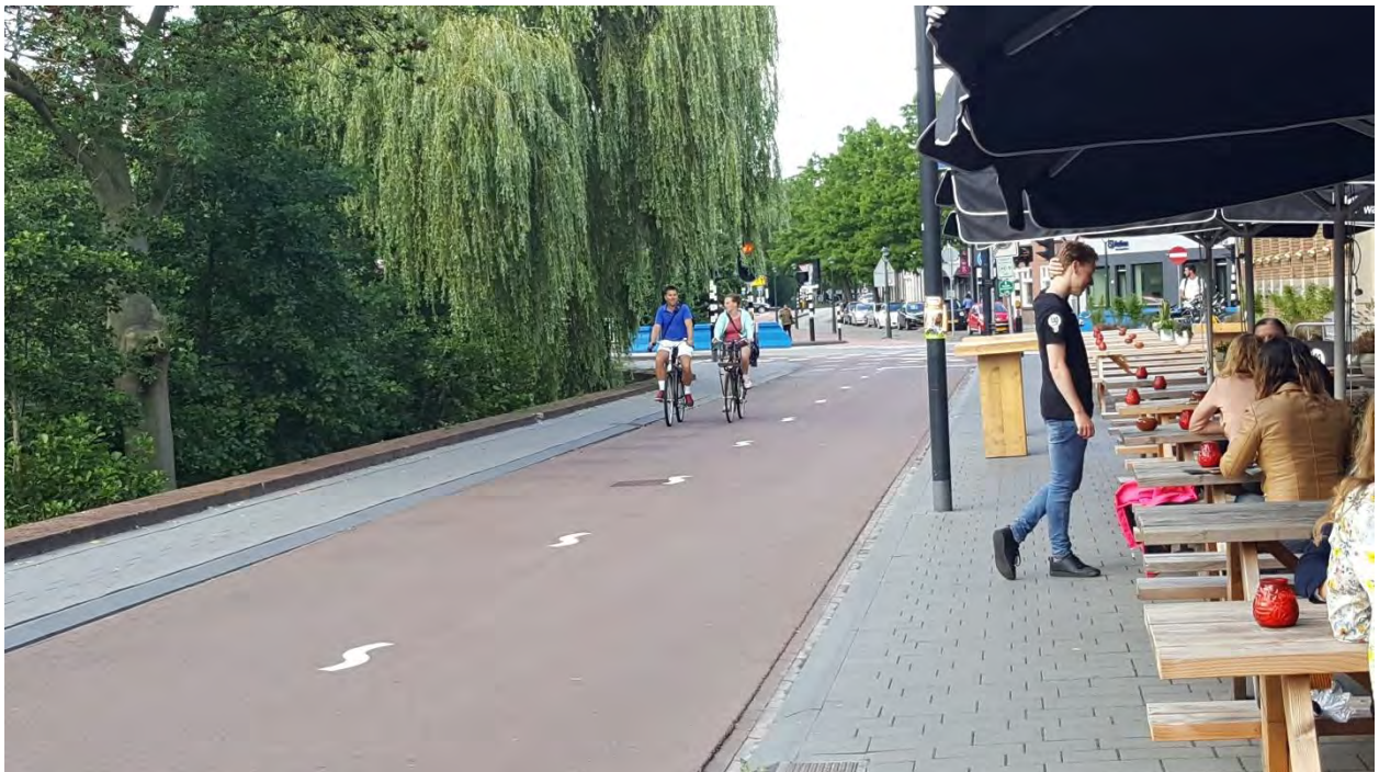
Abbildung 107: Subtile Markierung als Routenführung (Slowlane Eindhoven).
