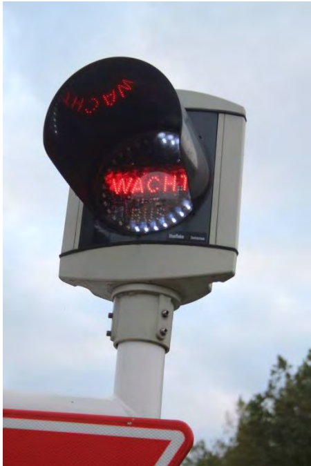
Abbildung 110: Indikator für die Wartezeit, Leeuwarden (Niederlande). Quelle: Eigenes Foto.
