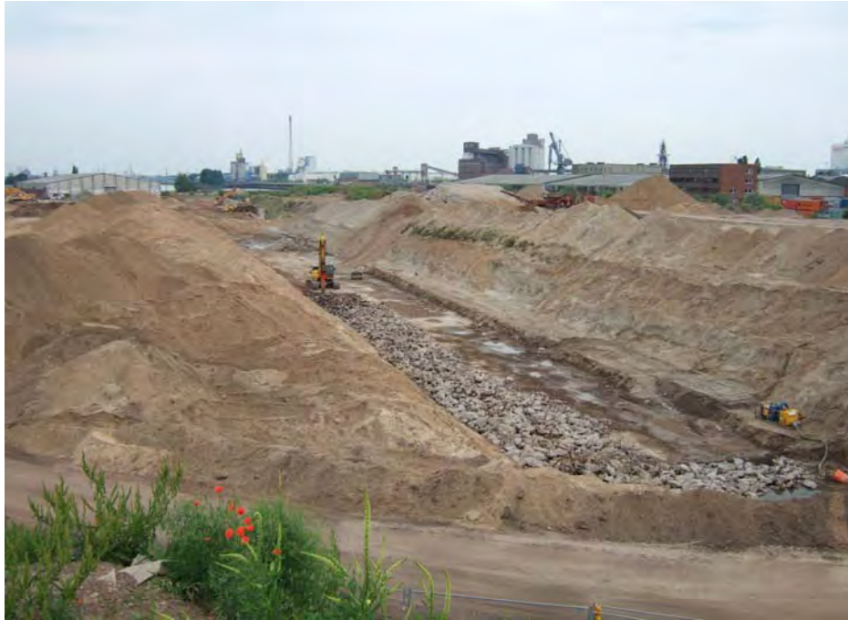
Abb. 46 Rückbau der Kajenkonstruktion auf der Südseite des ehemaligen Überseehafens
