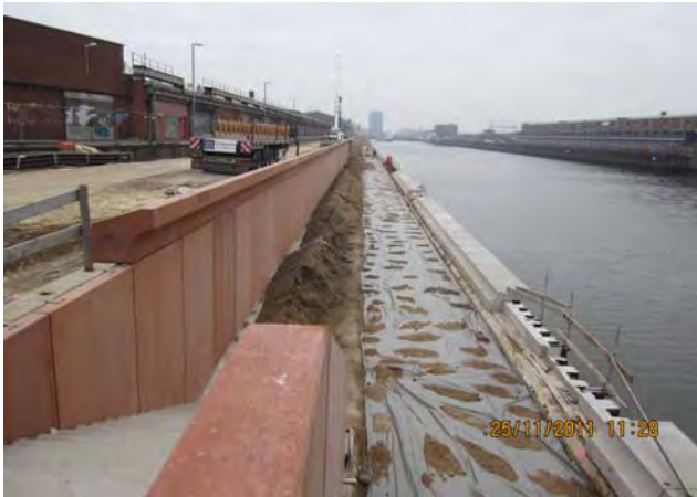
Abb. 21 Vorhangfassade mit oberem Kajenkopf, untere Promenade und unteren Kajenkopf
