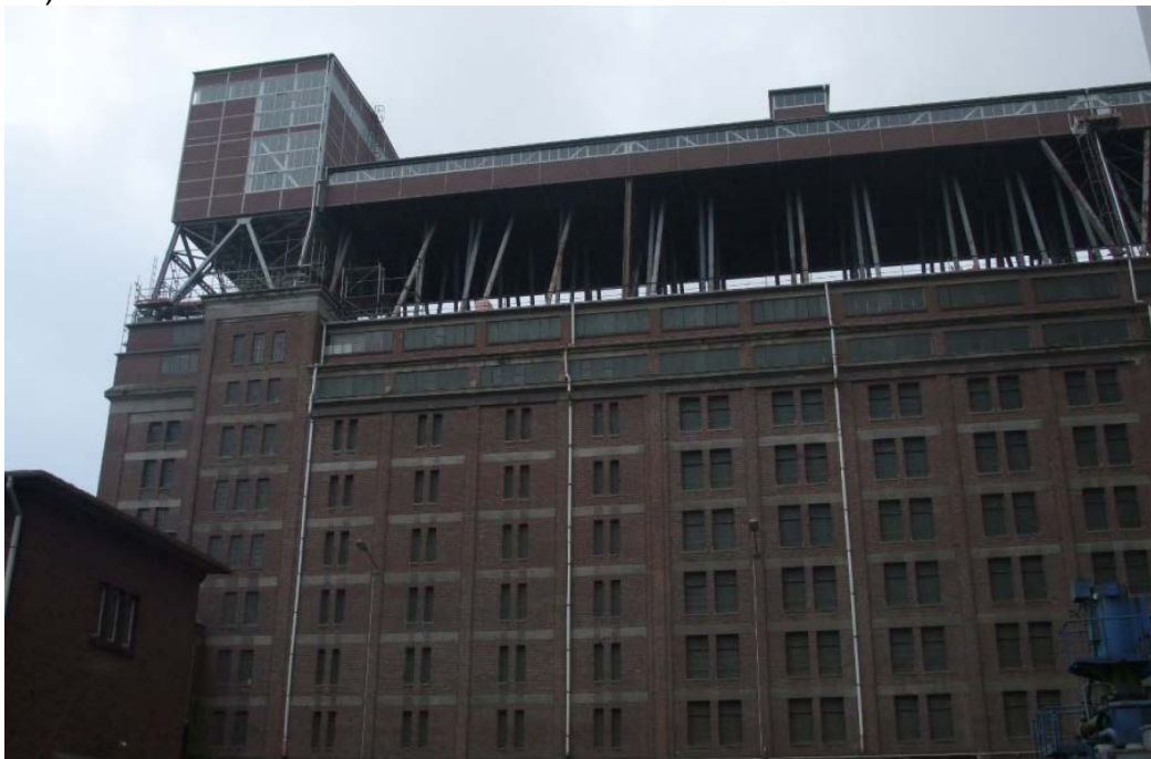
Abb. 22 Kopfstation der Getreideverkehrsanlage mit Bandkanal auf Silo 1 (Quelle: WFB)
