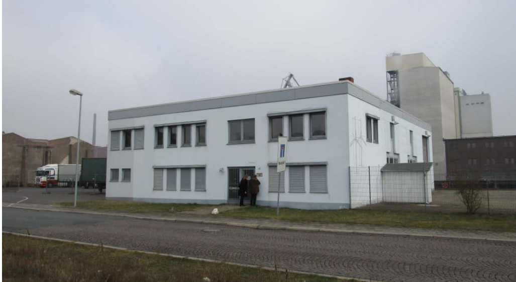
Abb. 26 Büro- und Werkstattgebäude Am Holzhafen 21 (Quelle: WFB)#
