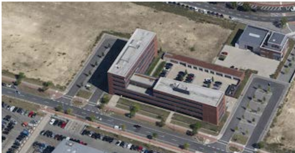
Abb. 43 Hauptzollamt und dahinter Firma Albright (Quelle WFB, Studio B)
